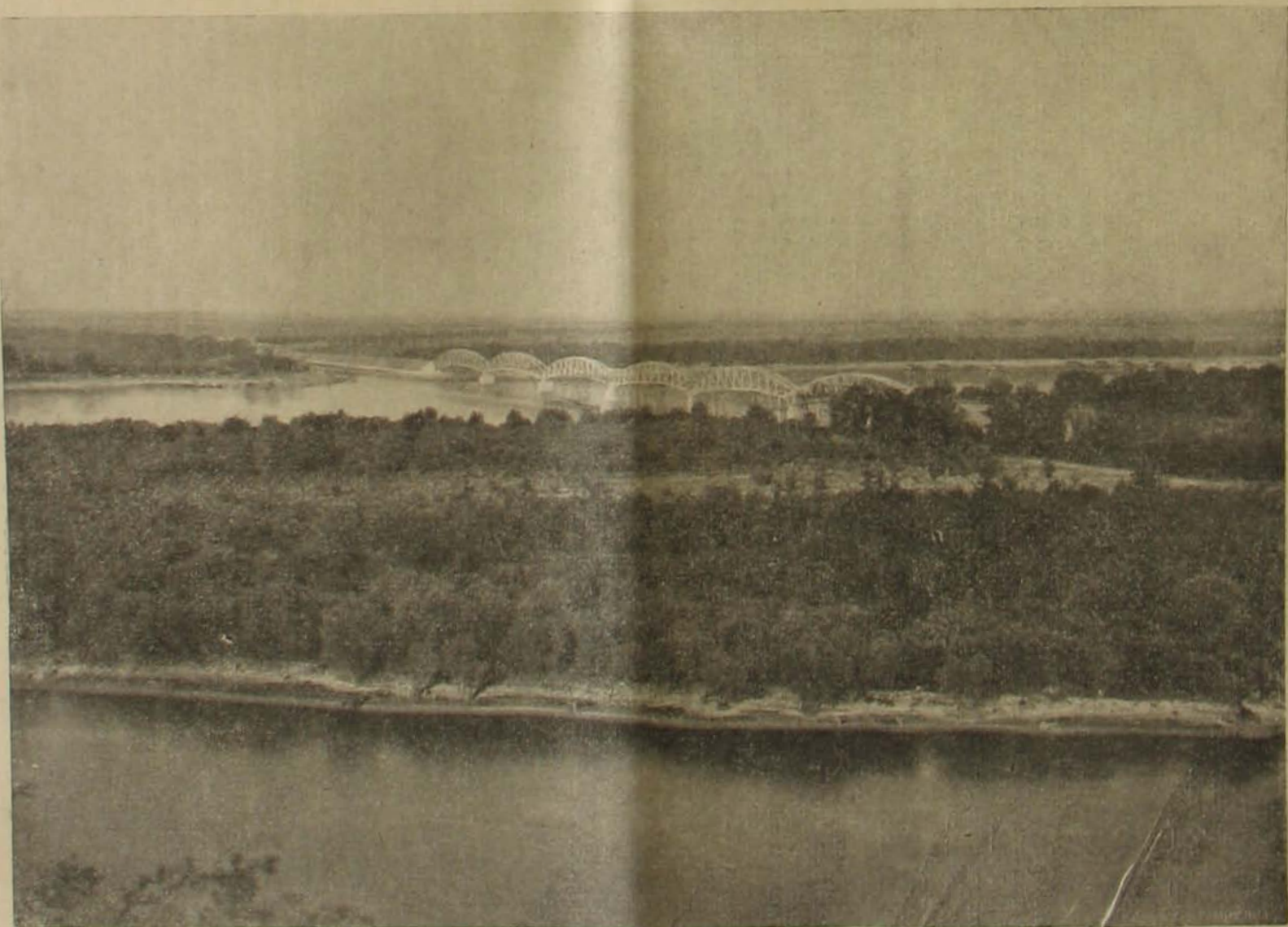
A gombos-crdődi új vasúti Duna-híd. — A híd látképe.
